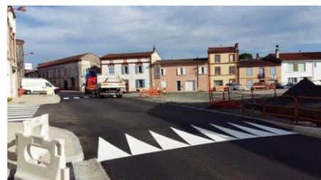
Avec 7% de pente, il respecte les normes et les prérogatives des services du département. On peut d'ores et déjà constater le ralentissement des véhicules. Il sera accentué par la réalisation d'une résine gravillonnée qui colorera l'ensemble du plateau d'une teinte similaire à celle des trottoirs marquant ainsi visuellement la priorité piétonne de cette zone 30.
