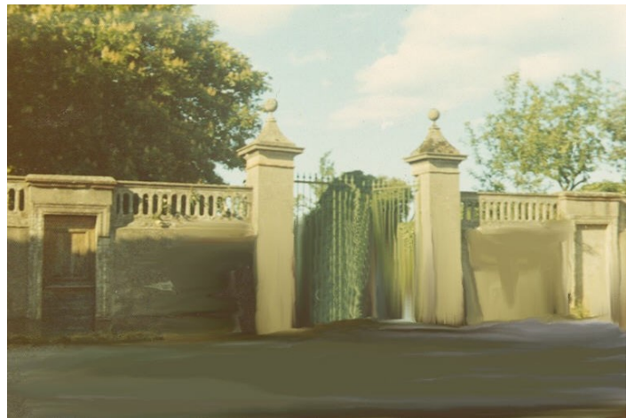
L'entrée du Château.
