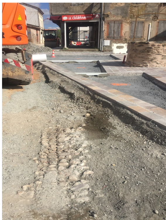
Les traces de la rue pavée
