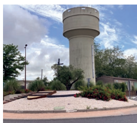
► Réfection du rond-point.
