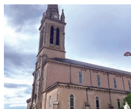
► Église Villefranche - Réfection paratonnerre.
